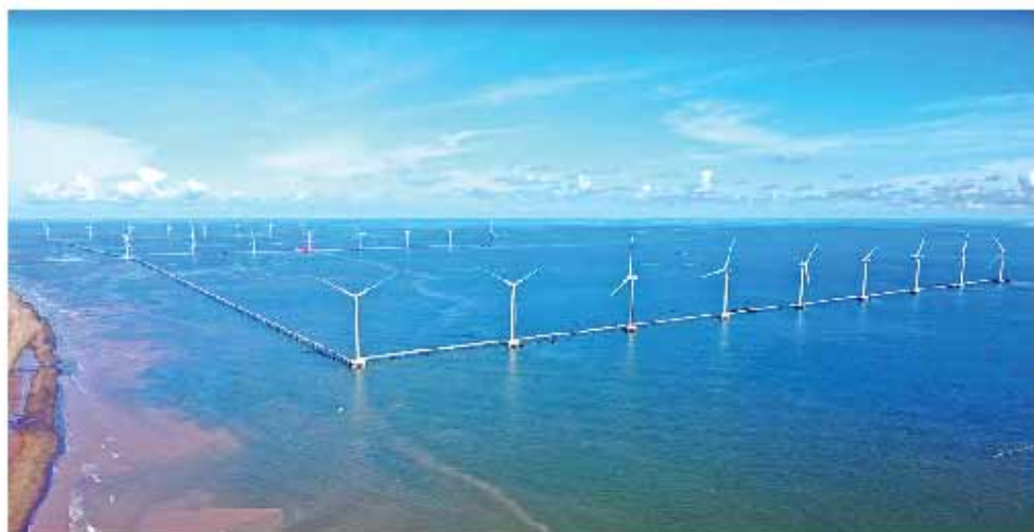
Phát triển điện gió trên địa bàn tỉnh - Ảnh: Sở Công Thương
